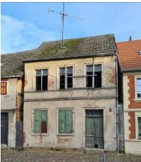
Das zweigeschossige Objekt, in der Nähe zur westlichen Wallanlage und zum Dosseteich gelegen, steht seit vielen Jahren leer und weist erhebliche Schäden an der Fassade und dem Sockelbereich auf. Im Jahr 2020 wurden vom Eigentümer erste Bemühungen um eine Förderung für die Sanierung eingeleitet.
